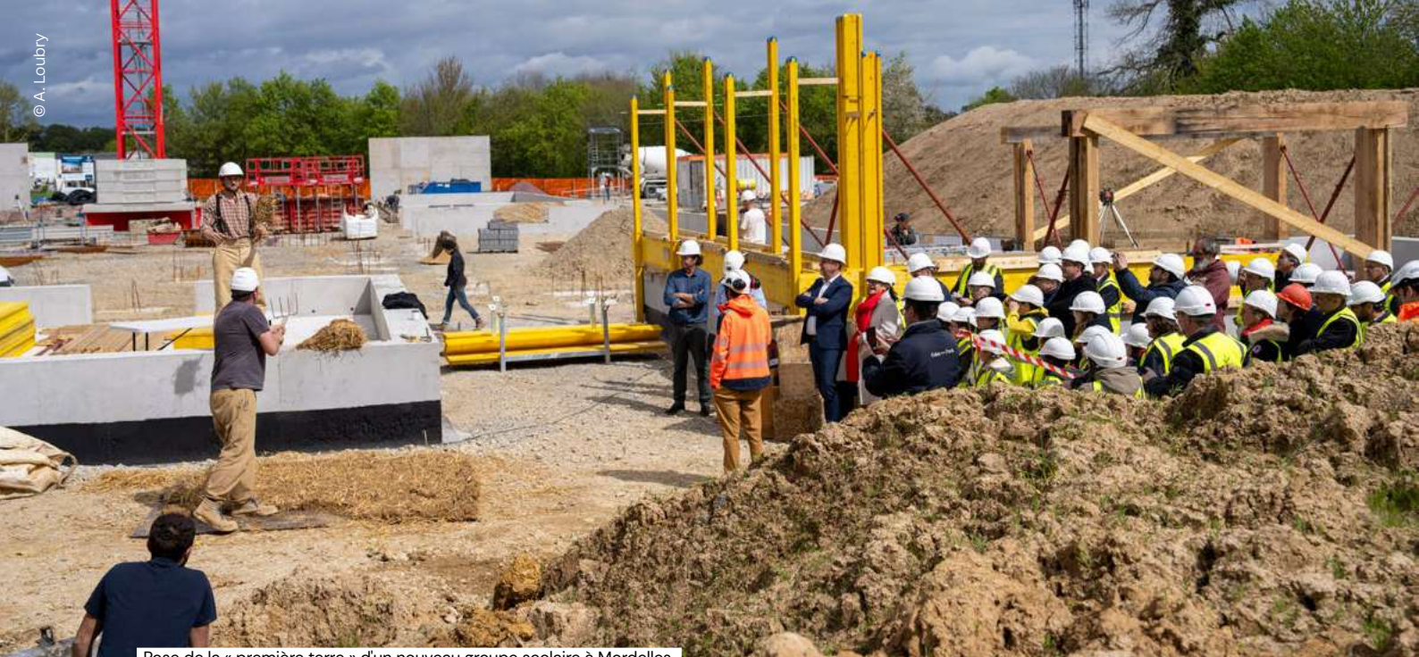
Pose de la « première terre » d'un nouveau groupe scolaire à Mordelles.
