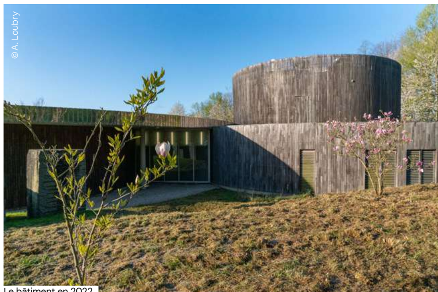
Le bâtiment en 2022.
