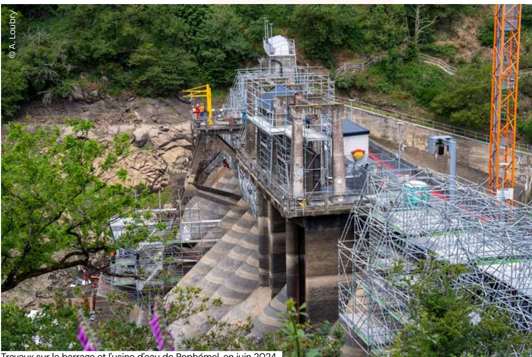
Travaux sur le barrage et l'usine d'eau de Rophémel, en juin 2024.
